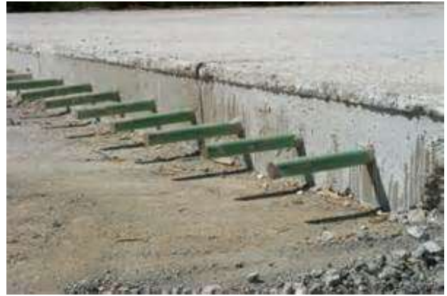
الصورة رقم (28): المفاصل الانشائية للتبليط الصلب
