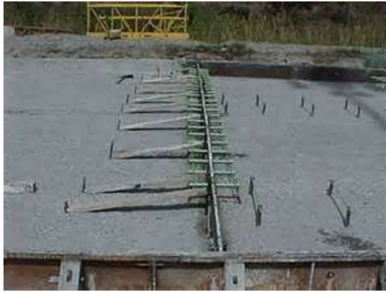
الصورة رقم (28): المفاصل الانشائية للتبليط الصلب
