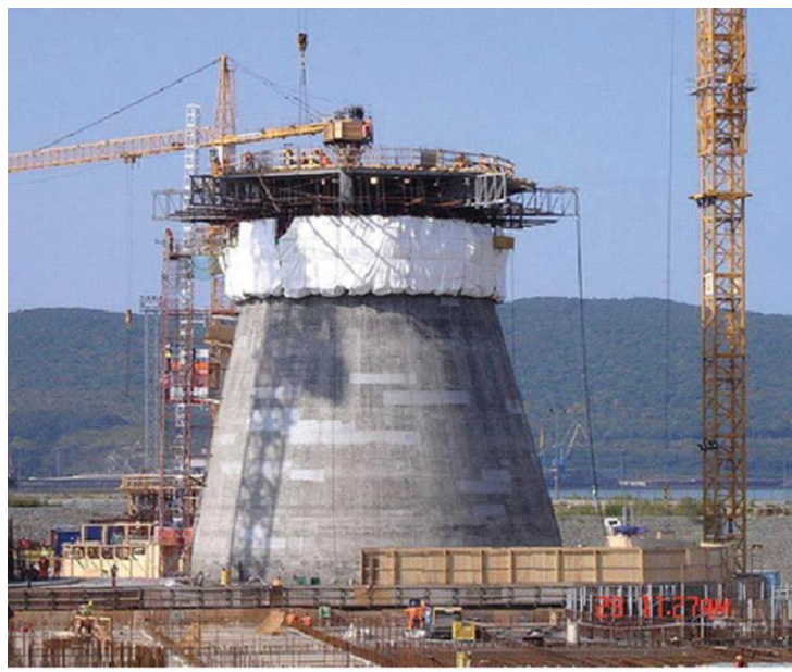
صوره توضح الحركة الرأسية للتشدات المنزلقه
