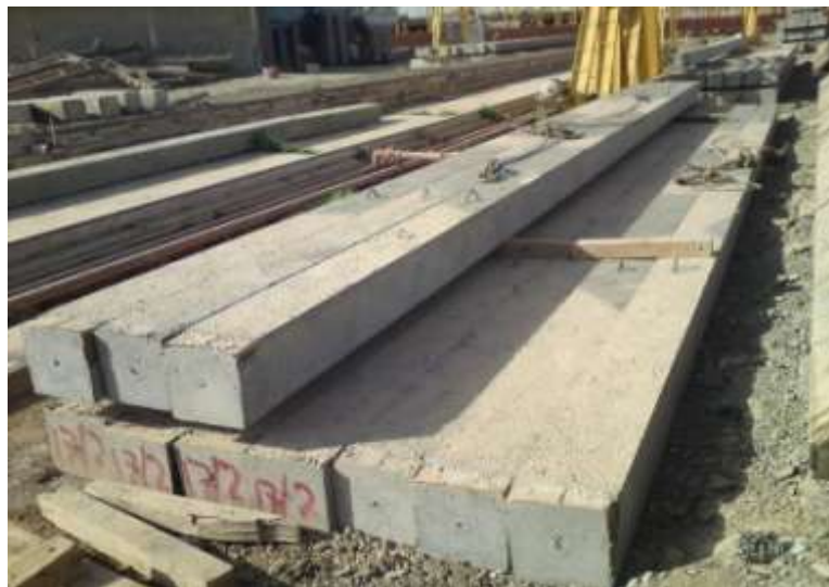
الصورة رقم (12): عملية تسليح وصب ركائز كونكريتية داخل القوالب الحديدية
